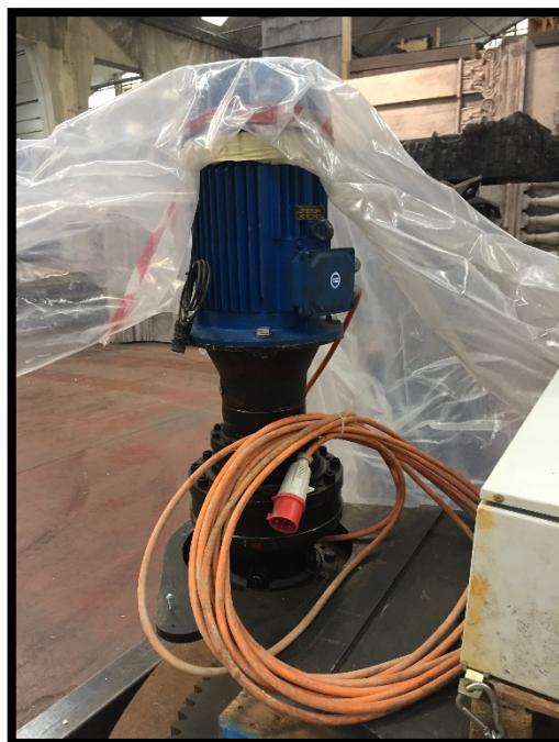
IMG20 dettaglio motore
