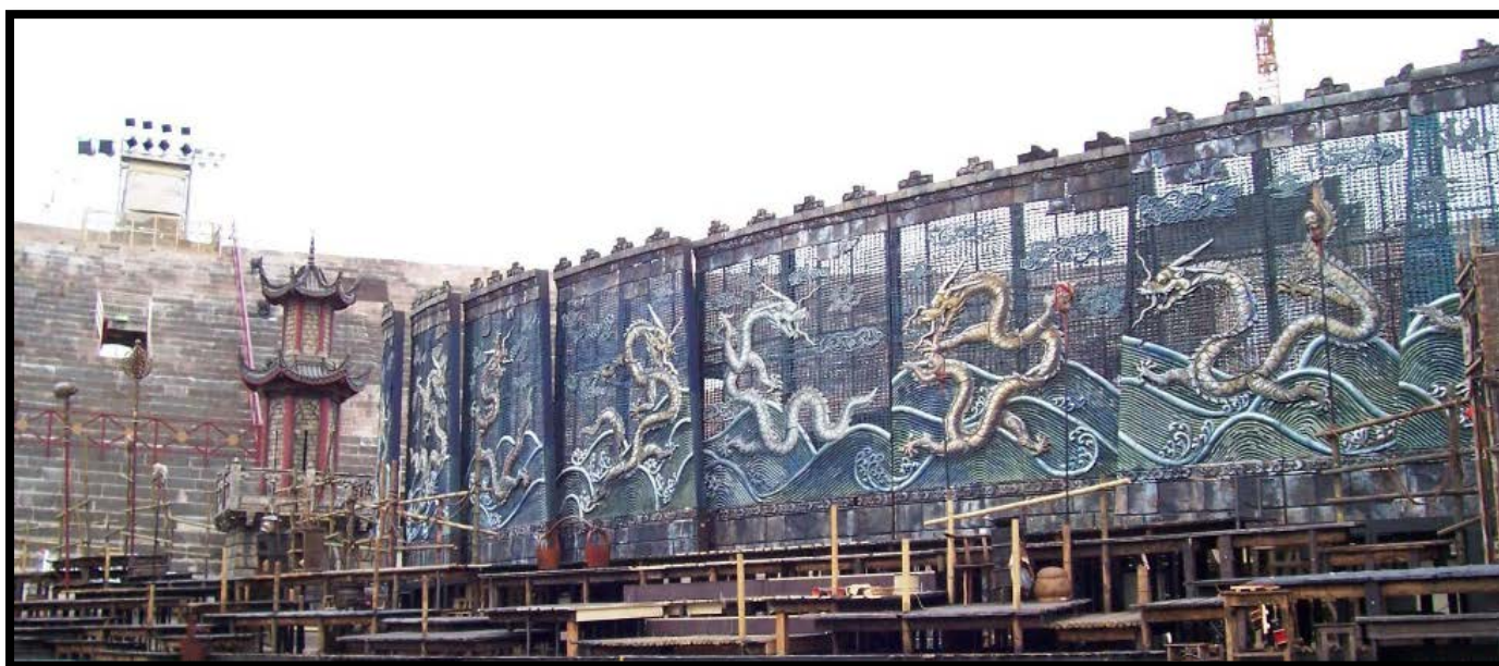
IMG8 pannelli a montaggio ultimato
